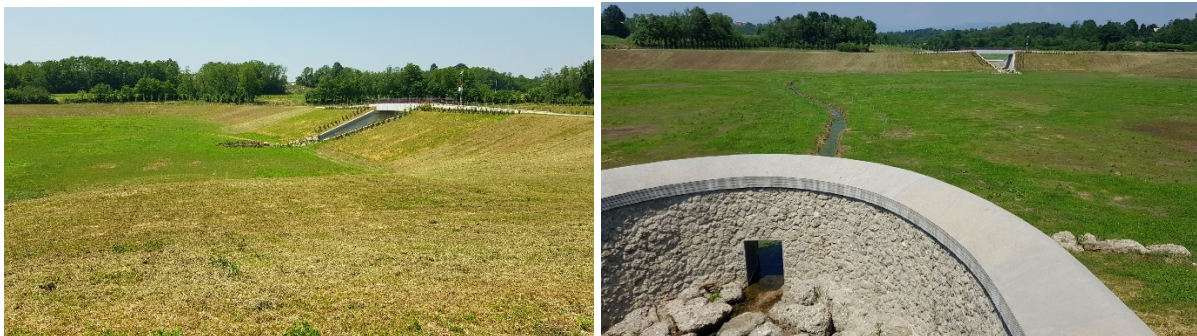
Figura 6 – Manufatto di restituzione (vista da valle e vista soglia di sfioro con luce di scarico)
