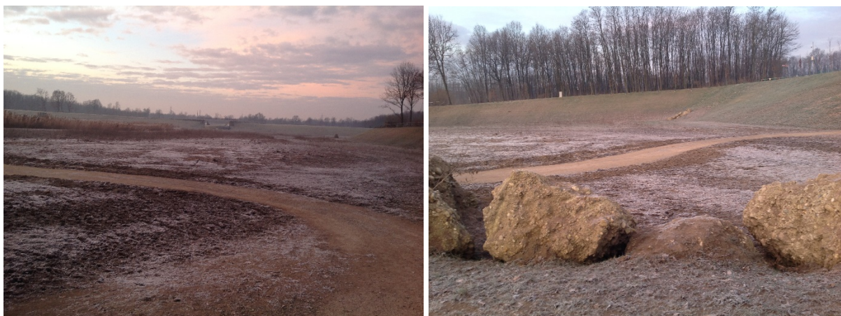
Figura 24 - esempio di sedimentazione all'interno vasca torrente Lura a Lomazzo post evento invasivo e lavorazione in attesa della semina
