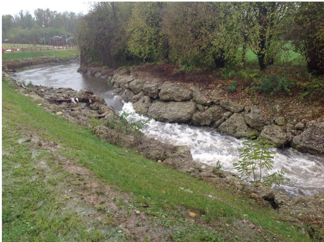
Figura 4 –restringimento in massi sul torrente Lura a Lomazzo
