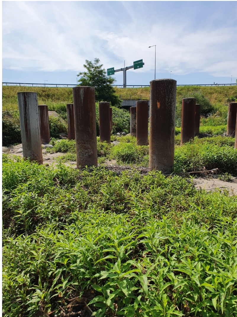
Figura 25 - primo piano briglia a pettine a monte autostrada
