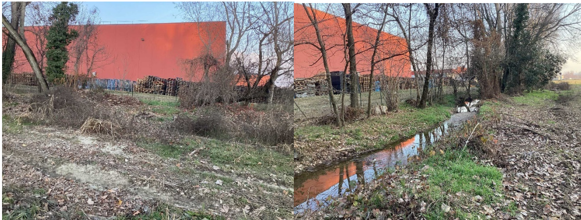
Figura 14 - tratti di torrente Lusert con e senza arginatura in destra
