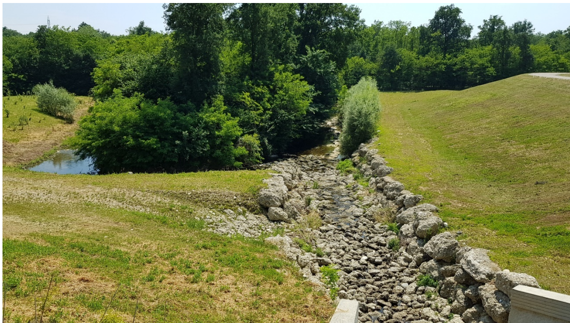
Figura 21 - nuovo tratto di alveo similare realizzato sul torrente Lura a valle del manufatto di regolazione
